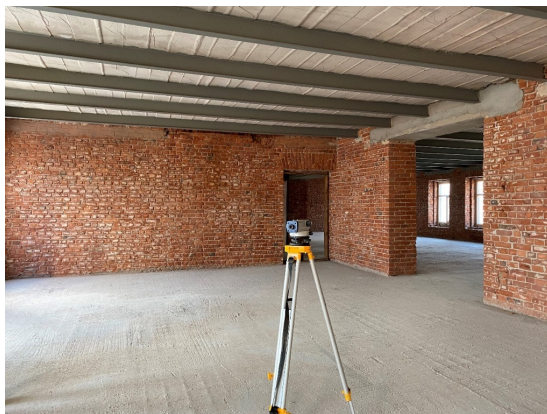
Рис. 2. Расположение приборов и вид балки снизу
