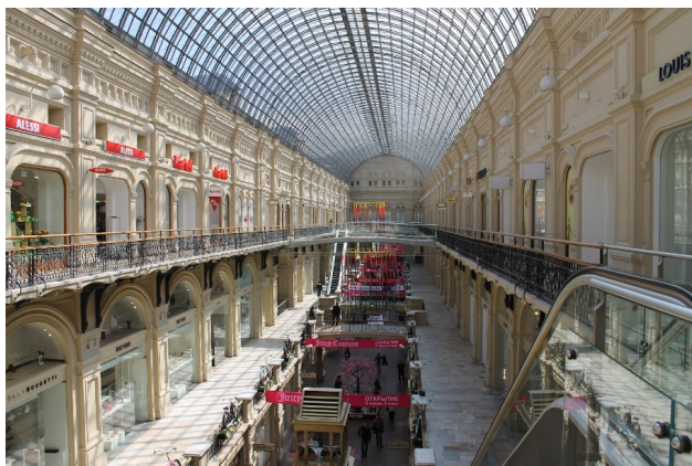
Рис. 5. ГУМ в г. Москве (Россия): установленные в зале эскалаторы
