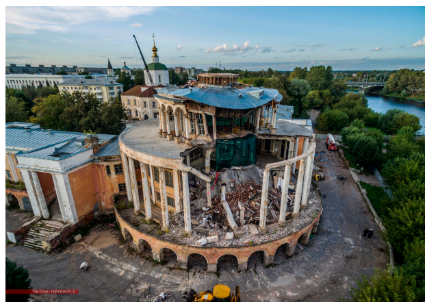
Рис. 3. Современное состояние Речного вокзала
