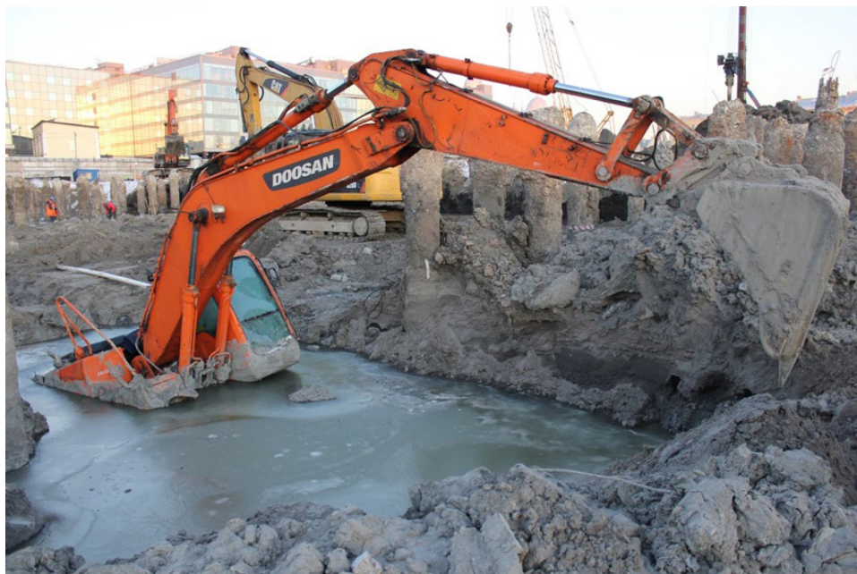
Рис. 1. Разработка грунта для водопонижения зумпфов
