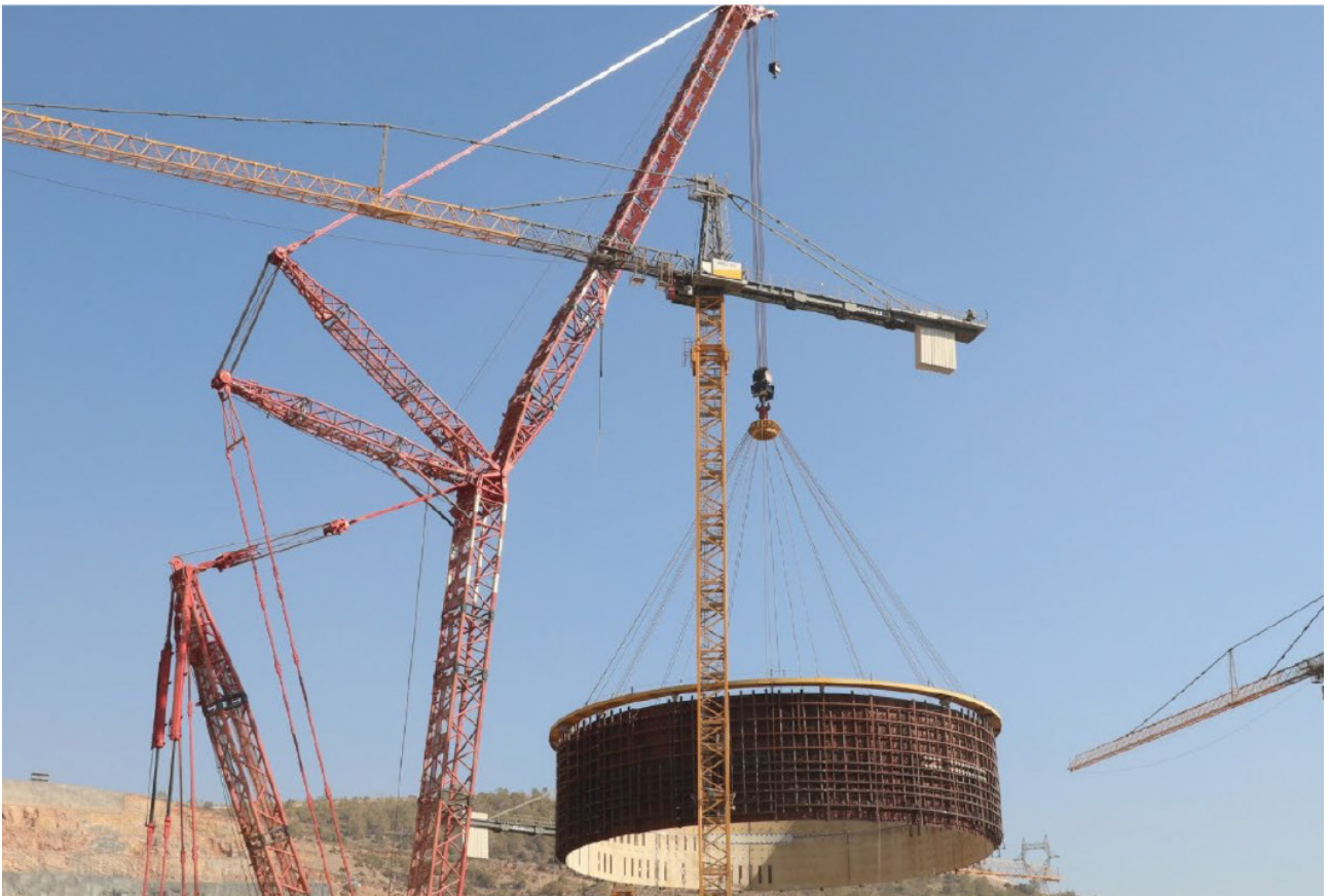
Рис. 3. Монтаж яруса внутренней защитной оболочки (ВЗО) на здании реактора АЭС «Аккую»
