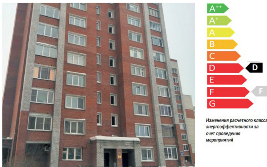
Рис. 7. Производство работ в Новосибирской области
