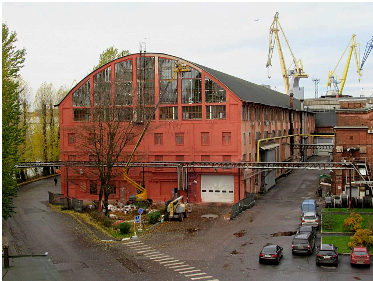
Рис. 1. Фотография общего вида здания подплавового участка лит. АЦ
