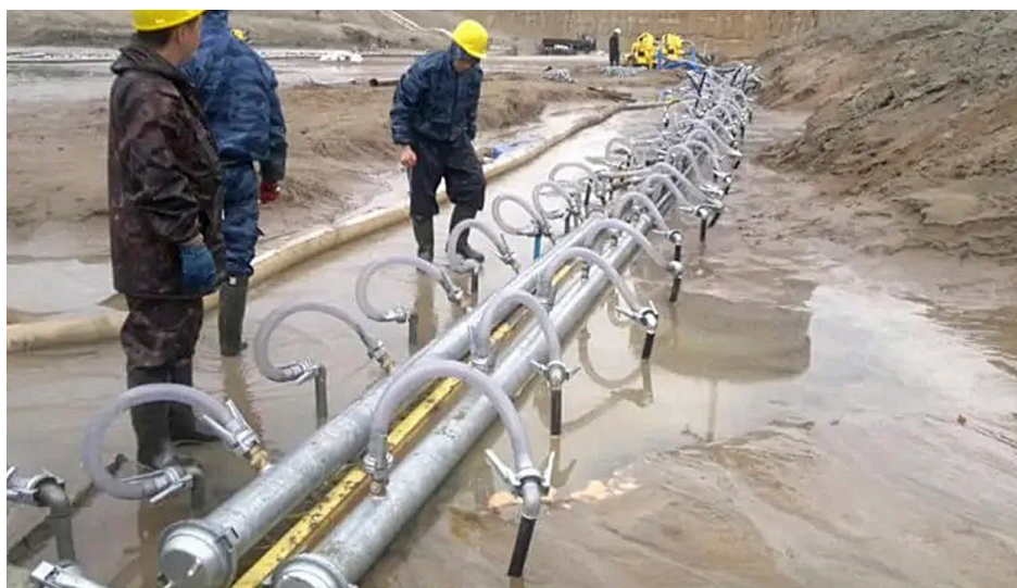
Рис. 3. Оборудование строительной площадки иглофильтрами
